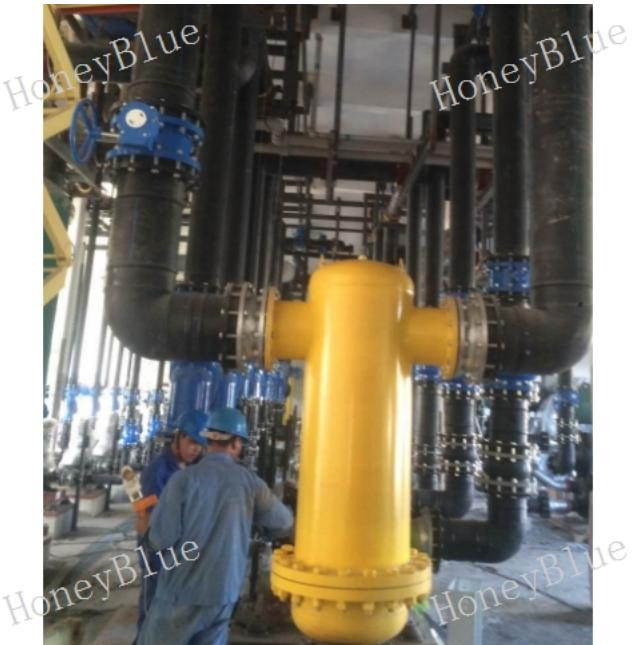
全自动刷式过滤器原理：通过出水口电接点压力表检测进出口压差变化，当出水压差达到设定值时（下限值），电控器向控制阀、电动机发送信号，引发下列动作：电动机带动转轴旋转，排污电磁阀打开，滤筒内部吸装置在内压作用下将滤筒内壁的杂质吸入排污系统，全自动刷式过滤器通过排污电磁阀排出，从而起到对滤芯进行清洗的作用。整个清洗过程将持续60-90秒，当出水压力值达到设定值时（上限值），排污电磁阀关闭，电动机停止转动，系统恢复至其初始状态，全自动刷式过滤器为下一个过滤工序做好准备。自清洗过滤器是一种高效、节能、环保、绿色的全自动水过滤设备，滤元采用高精度、度不锈钢或合金烧结网，清洗方式采用滤网外侧2.0Mpa高压反冲洗与滤网内侧自动吸污同步工作的模式。过滤器，就选喜蓝（上海）环境科技有限公司，用户的信赖之选，欢迎新老客户来电！合肥全自动刷式过滤器公司
